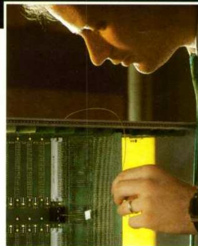
La instalación masiva de fibra óptica en el bucle de abonado y otras redes de comunicación, conllevará un notable incremento en el uso de elementos basados en nuevas tecnologías.
